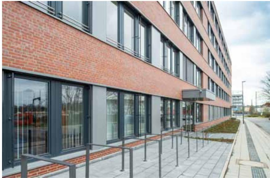
Hochwertige Fassaden sind auch in Modulbauweise möglich. Hier: Keramische Klinkerriemchen, mit liegenden schmalen Fensterbändern gegliedert, strukturieren die großen Gebäudeflächen. Graue Alufelder lockern die strenge Fensterreihung auf und sorgen für einen spannungsvollen Materialwechsel.
