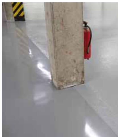
Die Halle wurde in verschiedenen Abschnitten beschichtet. Links der Produktionsbereich mit Epoxy ESD Color 3K und rechts die fertigen Lagerflächen und Fahrwege mit Epoxy SIC Color ESD.
