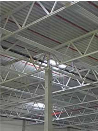
Durch die geringe Aufbauhöhe von 50 mm konnte jedes Strahlband in die Konstruktion eingefügt werden.
