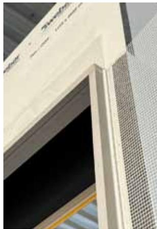
Die vorgefertigten Fensterelemente werden im passenden Format und bereits mit Leibungsplatten und Gewebeecken versehen auf die Baustelle geliefert.
