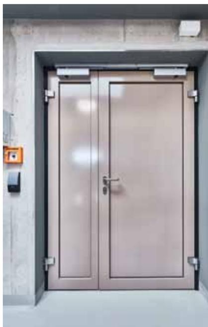
Rohrrahmentüren mit Paneelfüllung kamen in den Bereichen des Hotels zum Einsatz, die keine Gäste, sondern Hotelmitarbeiter durchqueren müssen. Sie wurden speziell mit Fluchttüröffner und einer bauseitigen Fluchtwegsteuerung ausgestattet.
