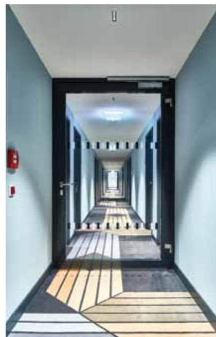
Die Brandschutztüren fügen sich überall ins reduzierte Design des Hotels ein. Verbaut wurden dafür auf den Fluren, Gängen und Zugängen zum Parkdeck des Hotels insgesamt 34 Rohrrahmentüren aus Aluminium. Als Rauchschutztür RS und in der Feuerwiderstandsklasse T30, sowohl 1-flügelig (teilweise mit festem Seitenteil) als auch 2-flügelig.
