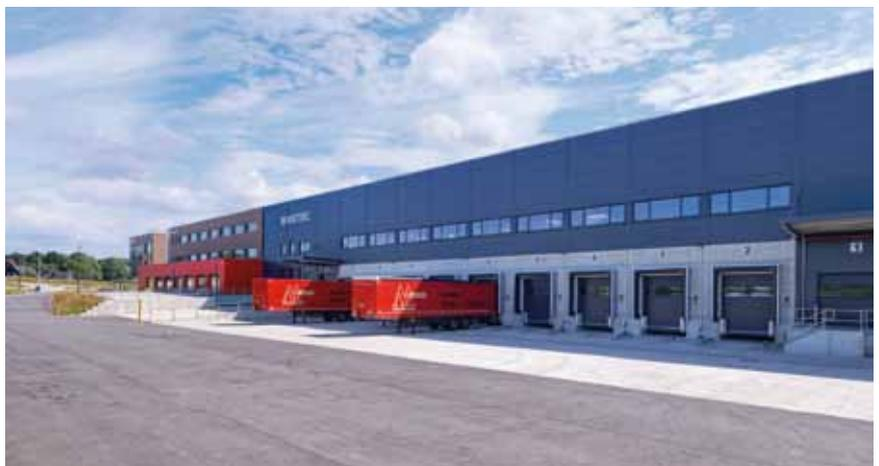
Die 12.000 m<sup>2</sup> große Lagerhalle beherbergt u.a. ein Hochregallager sowie ein Roboter-gestütztes Autostore Lager für Kleinteile. An neun Überladebrücken können die LKWs andocken.
