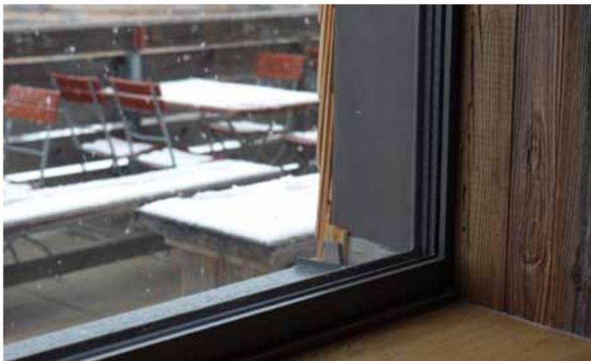
An die Fenster incl. Abdichtung werden auf 2.244 Meter hohe Anforderungen gestellt, denn sie werden extremen Wetterbedingungen ausgesetzt, TP654 bietet eine hohe Luftdichtheit – 100% besser als in der Norm gefordert –, Schallschutz bis 60 dB und Schlagregendichtheit bis 1.050 Pa.
